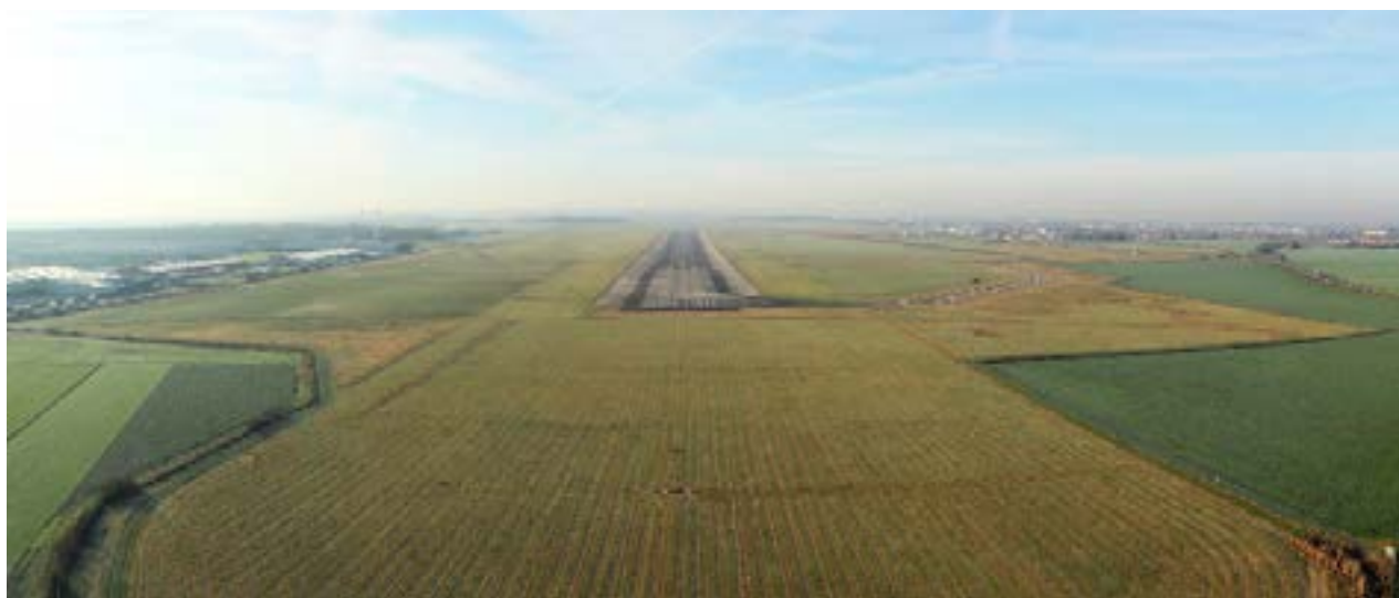
VUE AÉRIENNE DE LA L'ANCIENNE BASE 217
